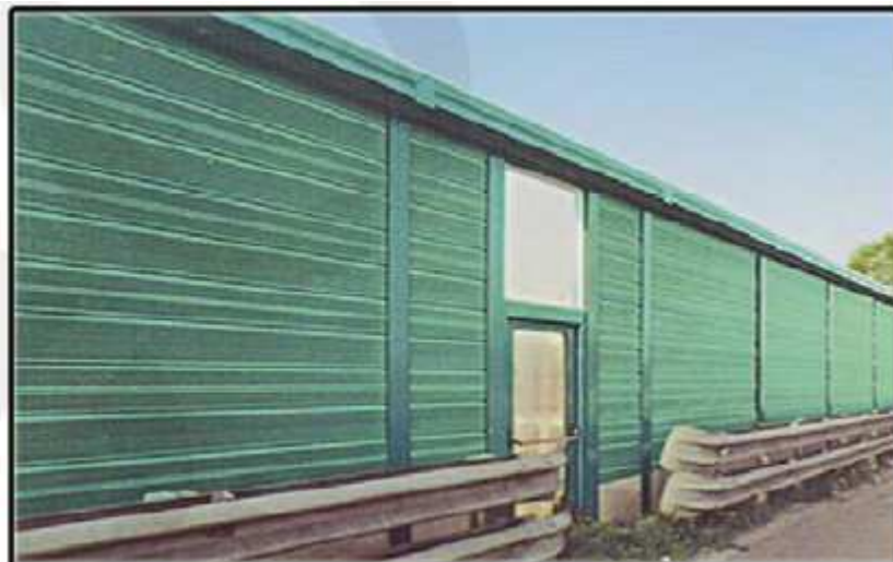
Figura 19: rilievi fotografici (barriere acustiche)
